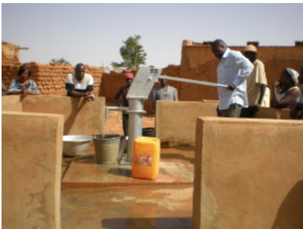
Images de la réception des ouvrages
