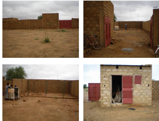
Le nouveau site de stockage en cours de construction
